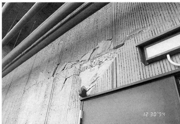
写真3-1 建物外壁の亀裂（八戸市内）
