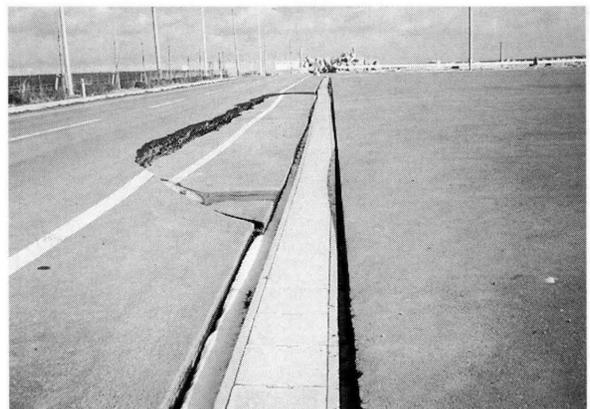
写真3-8b 八戸港八太郎地区の舗装面沈下
