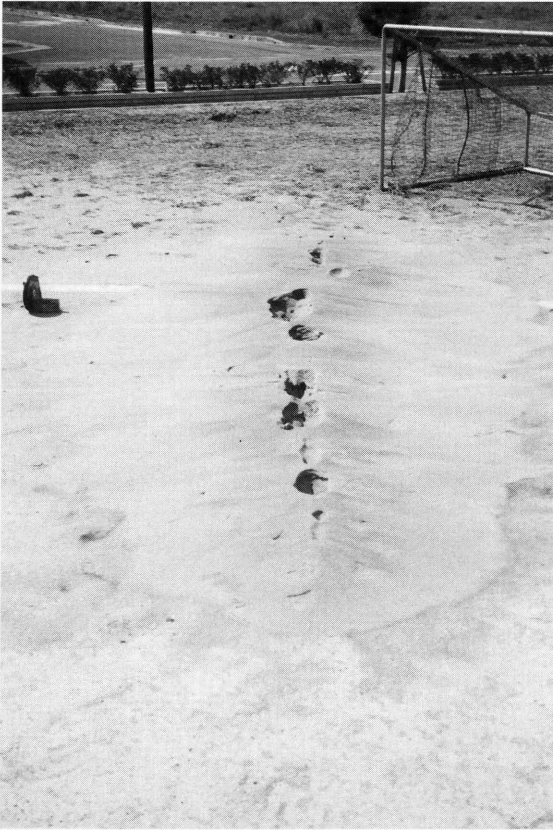
阿久根市漁港の隣接公園で見られた液状化現象 (No6)
