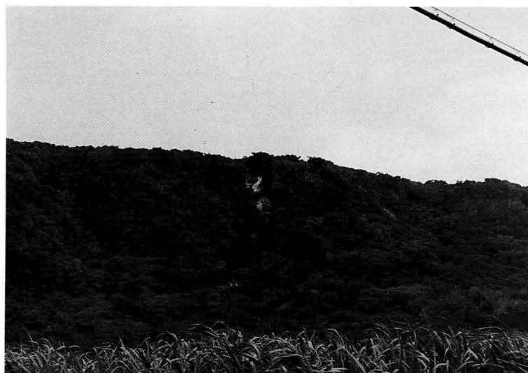
写真2. 浦原地区の山腹が山頂付近から崩壊した（喜界島）
