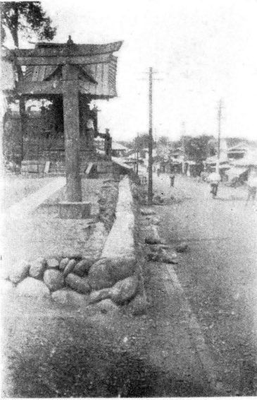
第五十五圖 比企郡松山町本町八雲神社東側石垣の破損
