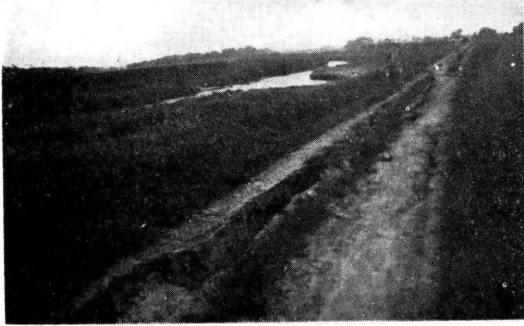
裂龜の防堤川根利先地塚石字大村戸明郡里大
