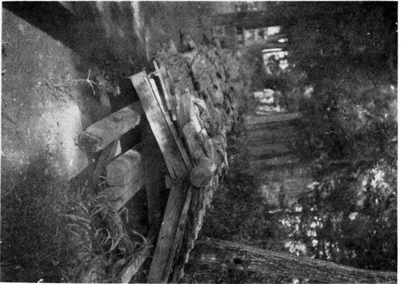
旗社神根上根上宇大村井長郡里大 潰倒の屋納抗 圖一十四第
