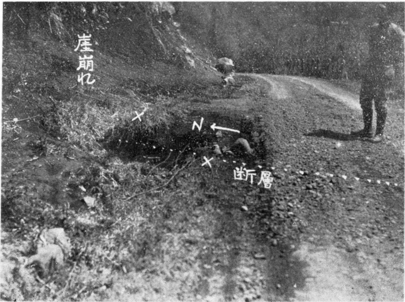
方東米百三約りよ代田) 層断の上道街海熱 圖五第 (ひ違喰の道街るけ於に點A風前
