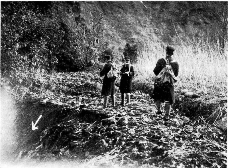
(點A 圖一第告報査踏震地豆伊北)れ崩山の畔川野狩近附根羽青 圖一十二第
