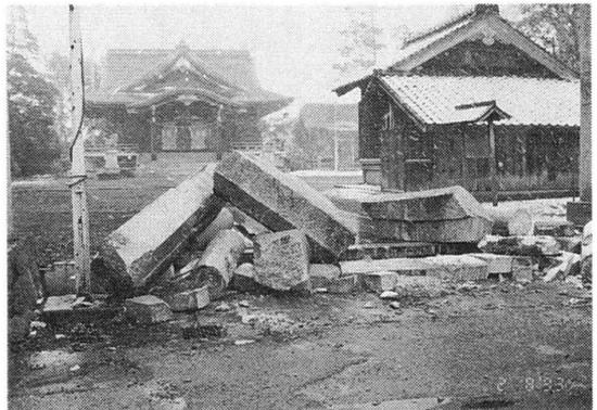
写真1 須受八幡宮の鳥居倒壊
