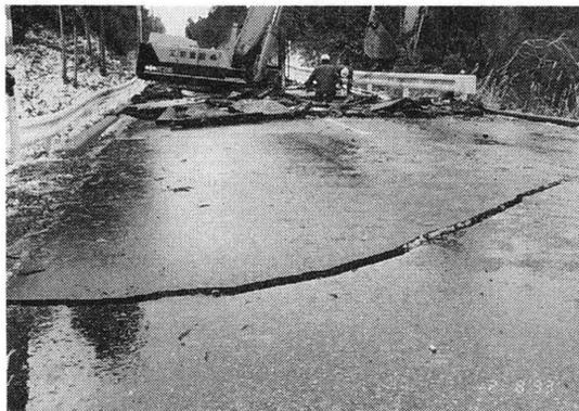
写真4 道路の損壊（陥没）
