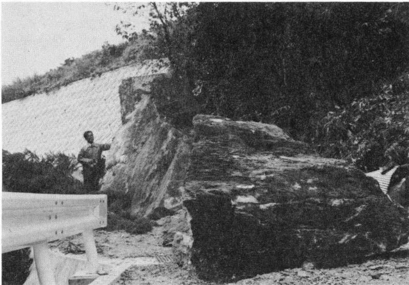
写真2 神倉の落石. 2.5 m×2.5 mの石(板状節理安山岩)が北側の丘(高さ5 m)から落下し, 道路をふさいでいる.
