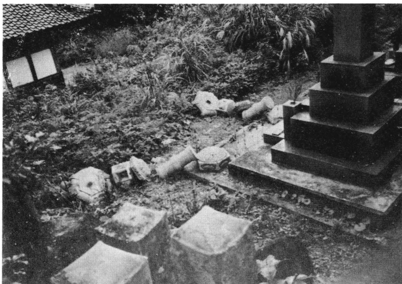
写真3 吉田の墓地の被害。手前の燈籠の倒伏方向は南東。
