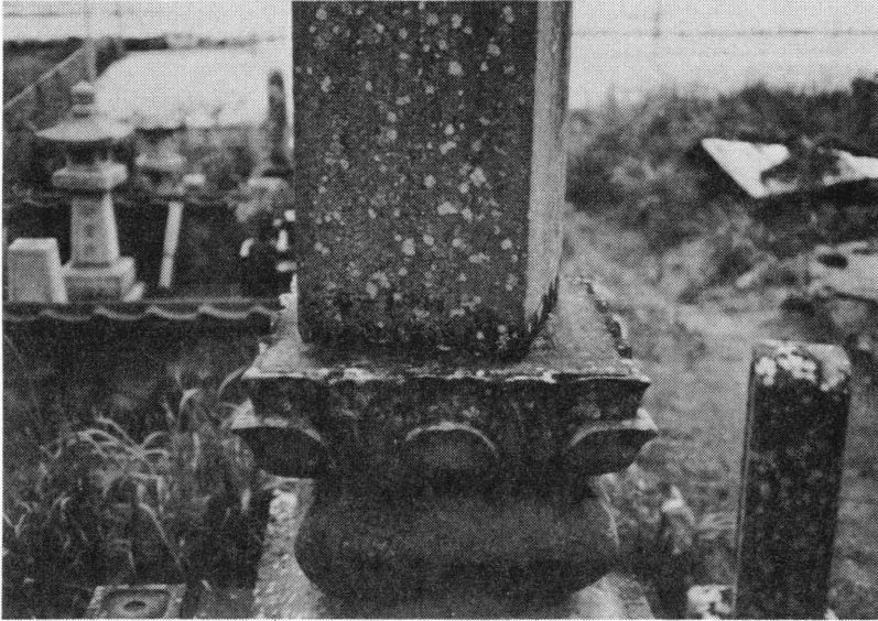
写真9 船磯の墓石の回転. 土台に対して約30°回転している.
