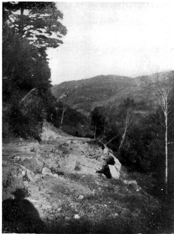
山の間湯の姫保原に爲の線層斷る走に西東 圖一十八第 よ方南・態狀るすとんれ崩や今路道れ崩腹 りたれさか脊に震餘時當影撮り
