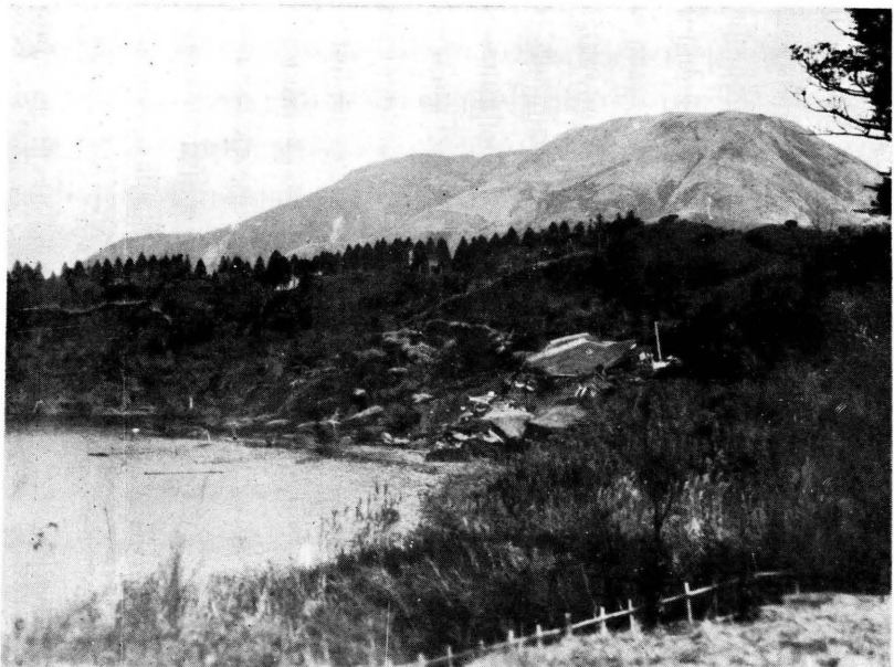
箱根町離宮の崩屋及び官舎の埋没 圖二十二第
