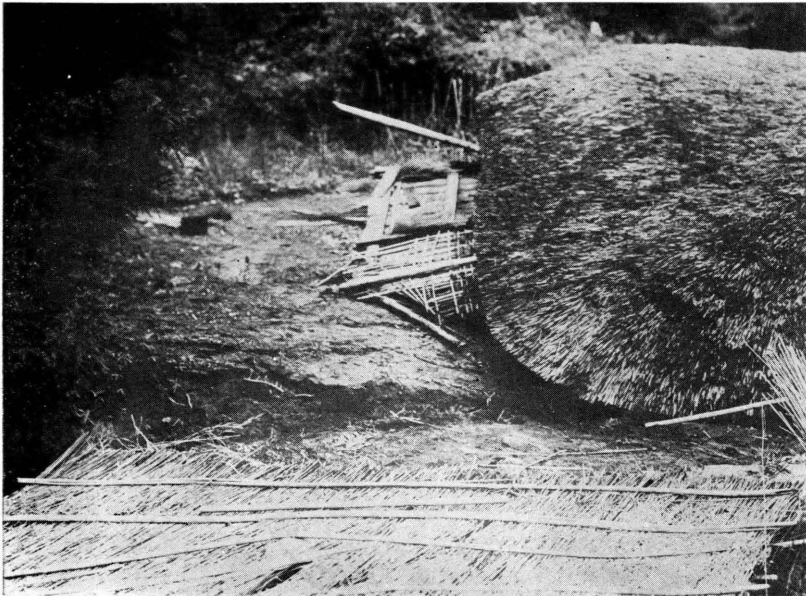
潰倒の家民の上層断るけ於に澤井輕 圖十五第
