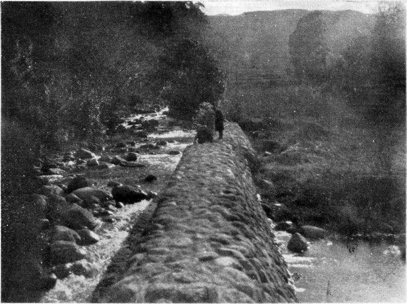
け於に上線層斷の西東)ひ違ひ喰の防堤るけ於に保原郡方田 圖三十八第 (りなのもる
