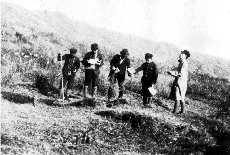
に更が部起隆す示を起隆の部力歴、罅裂形光電地山方北代田 圖七十三第 す動移に平水、し斷切に角直
