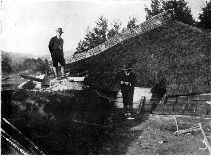
(五米一差落) 潰倒の家民の上層斷端南地盆那丹 圖九十六第
