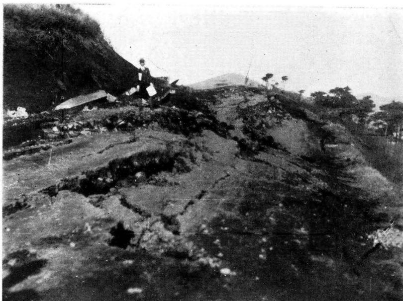
りな裂龜の路道の中途る到に町根箱りよ所候測山根箱 圖七十二第
