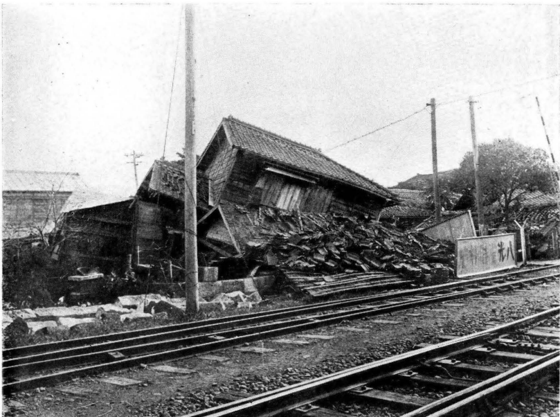
駿豆線沿線民家の潰倒 第六圖
