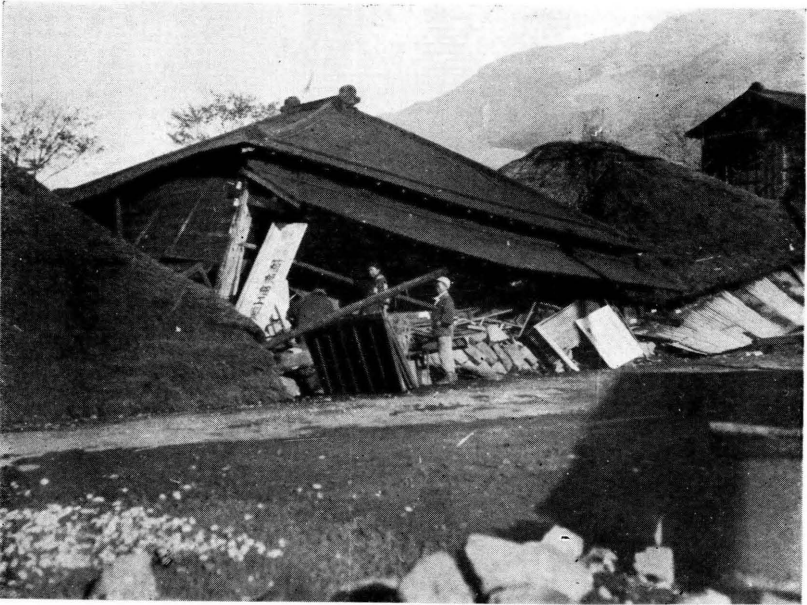
箱根町根箱の中央潰倒の屋家の傾きは側屋の根が其の儘落ちのもしりな 圖七十第
