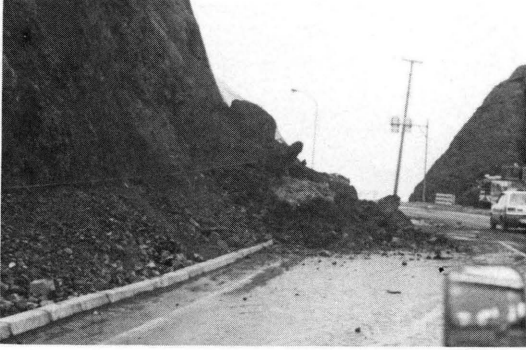
写真6.3.25 浦河町東町・月寒間の国道上の崖くづれ
