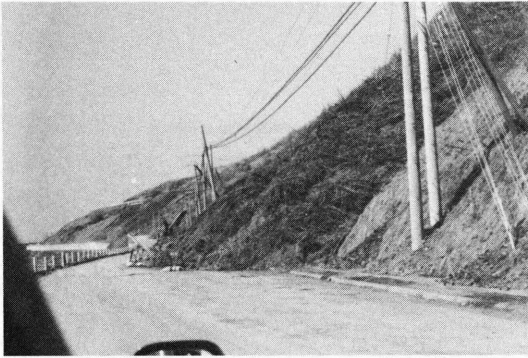
写真 6.3.7 静内町入舟付近の崖くづれ
