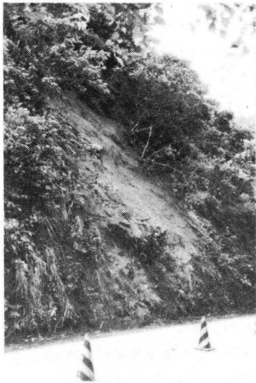
Photo. 2. 汐吹トンネル北方の土砂崩壊 (路面は清掃済みであった)
