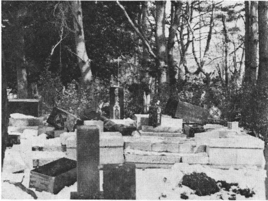
Photo. 1. 迫町天羽, 墓石の転倒状況
