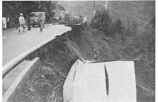
Photo. 5. 路肩の崩壊（河津町川横）
