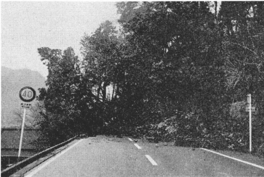
Photo. 2. 県道修善寺一下田線（河津町川横付近） をふさいだ土砂崩れ
