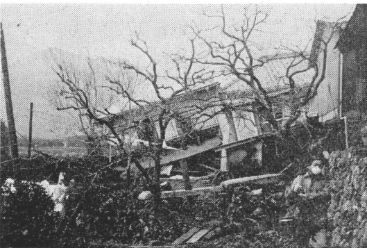
Photo. 3. 土砂崩れにより将棋倒しとなった母屋と 離れ（河津町川横）
