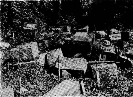
Photo. 25. 庄内町内山地区 墓石の転倒，方向は不定 1975年4月24日（福岡管区気象台撮影）
