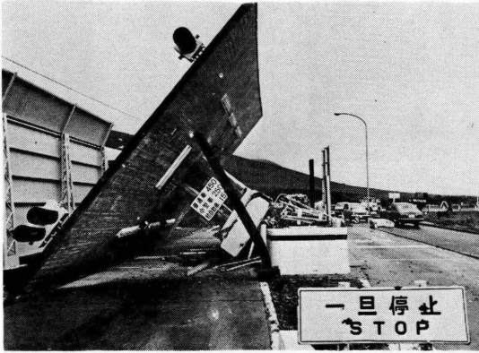
Photo. 8. 湯布院町小田野池付近 九州横断道路小田野池料金徴収所の倒壊 (西に倒れる) 1975年4月21日 (大分合同新聞社提供)
