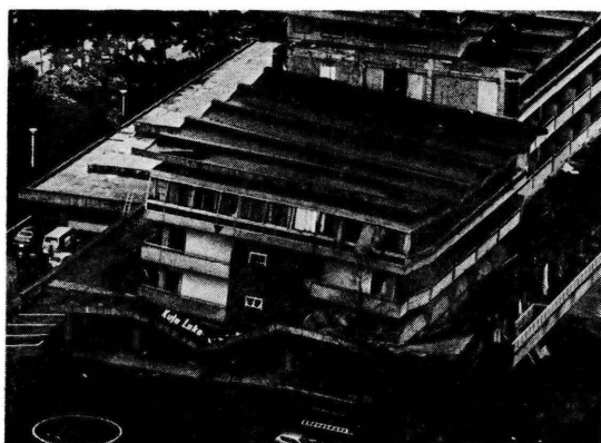
Photo. 1. 湯布院町山下池付近 九重レークサイドホテルの倒壊 1975年4月21日(朝日新聞社提供)
