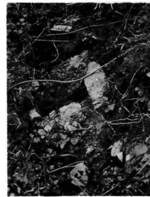
Photo. 36. 九重町奥双石地区崩部落 (前に同じ, 幅最大150cm, 深さ約150cm, 裂けた 長方形の石の配列は左ずれ断層のようなずれ方を している) 1975年6月30日(福岡管区気象台撮影, 第2次調査)
