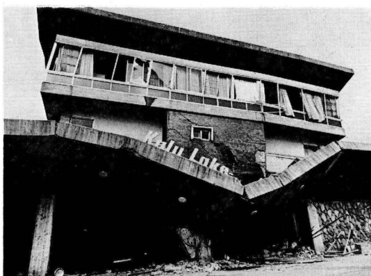
Photo. 3. 湯布院町山下池付近 九重レークサイドホテルの倒壊 1975年4月21日(大分合同新聞社提供)
