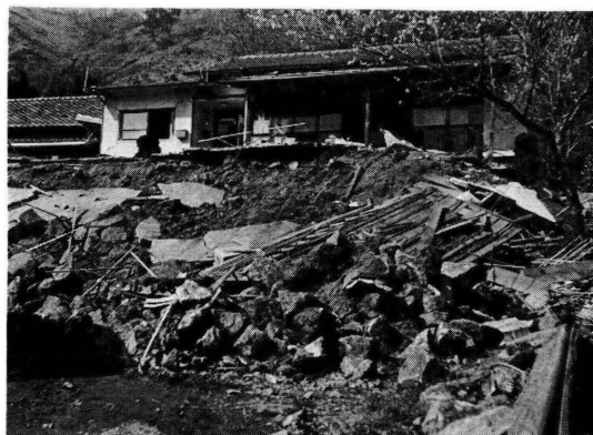
Photo. 17. 庄内町内山地区 石垣の崩壊 1975年4月24日(福岡管区気象台撮影)
