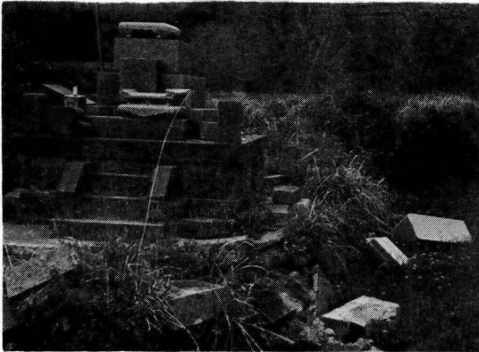
Photo. 38. 九重町奥双石地区 墓石の転倒(北へ)
