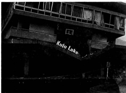
Photo. 2. 湯布院町山下池付近 九重レークサイドホテルの倒壊 1975年4月23日(福岡管区気象台撮影)
