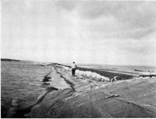
秋田県西部承水路堤防 WC14—WC15 の中間点で最も沈下し、コンクリート矢板は水中に没している、土で溢水を防いでいる。
