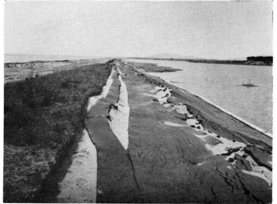
秋田県西部承水路堤防表面アスファルトの破損状況。中央で堤防に平行してき裂し、そこに周期的な盛り上りが見られる。
