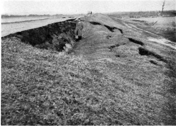
豊頃村幌岡，十勝川築堤の地割れと陥没（帯広測候所撮影）
