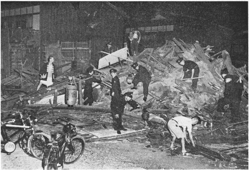
京都伏見区の倒壊家屋 (毎日新聞大阪本社提供)
