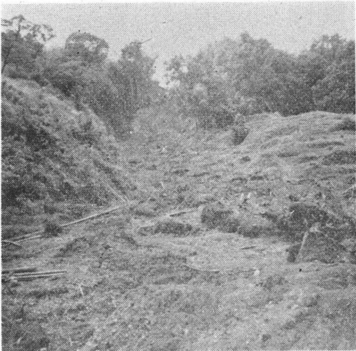
写真 6. 第2図A点より見上げたもの
