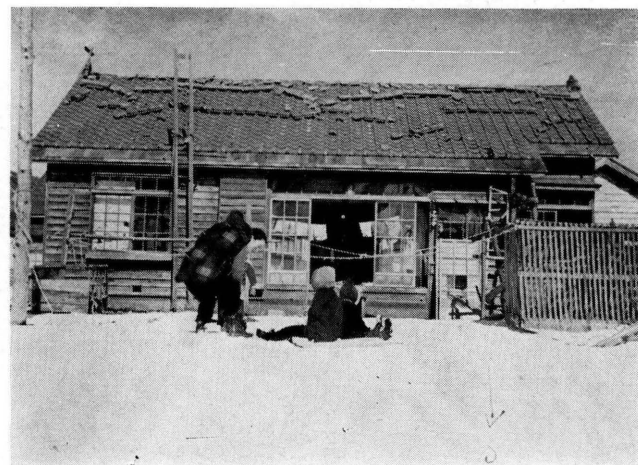
第39図 厚賀営林署官舎の棟瓦が南側の屋根に落ちている (苫小牧測候所報告)
