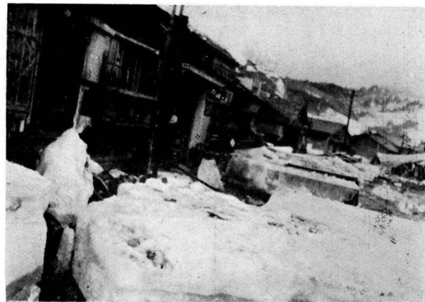
第15図 巨大な氷塊が民家に接触しながら少しも損傷を与えていない。(釧路測候所報告)
