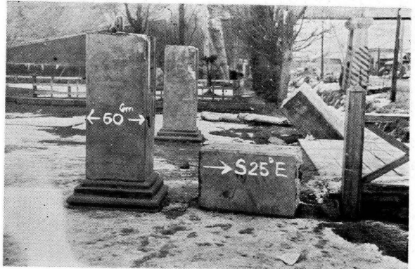
第29図 浦河小学校の門柱 200cm×60cm×60cm 転倒方向 S25° E
