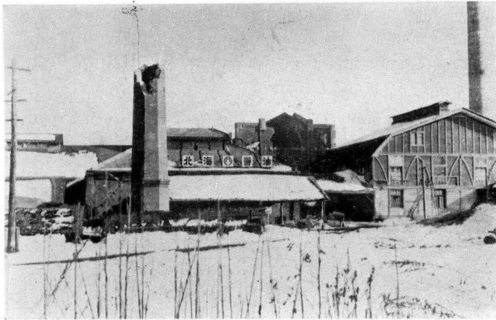
第22図 止若 新田工場における煙突の倒壊 左レンガ製 右鉄筋コンクリート製
