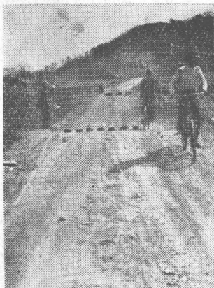
第十八圖。柳原部落の地溝狀地割れ f 部。
