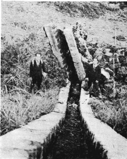
(5) 線路々盤の隆起により途中から折曲げられた排水溝 (堀割の上より寫す)
