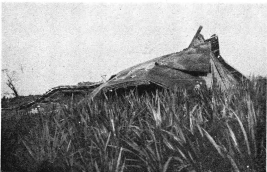
(4) 大分市大字下郡, 納屋倒壊
