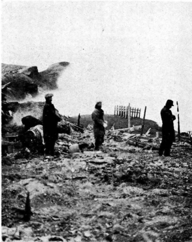
5. 火口縁上の被害 左側は甘酒茶屋の焼跡
