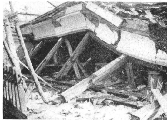
(寫眞 2) 船川港に於ける倒潰家屋
