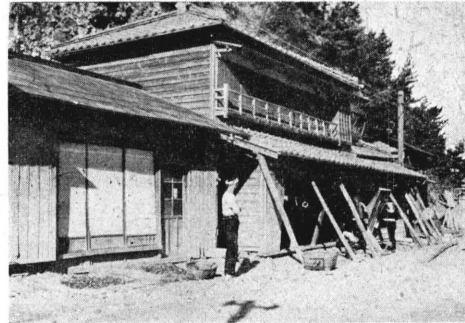
第9圖 福島縣石城郡江名町大字折戸の家屋の裏山の崖崩れによる被害
