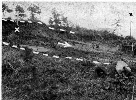
（寫眞12）男鹿中村小増川左岸の地すべりで二つの×印は切斷された一本の電柱の上部と下部とである，人の立つてゐる面が鏡肌である
