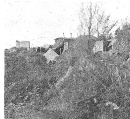
(寫眞 4) 寫眞 3 の山崩れの上の貯水槽の 破壊, これは地中であつたもの
