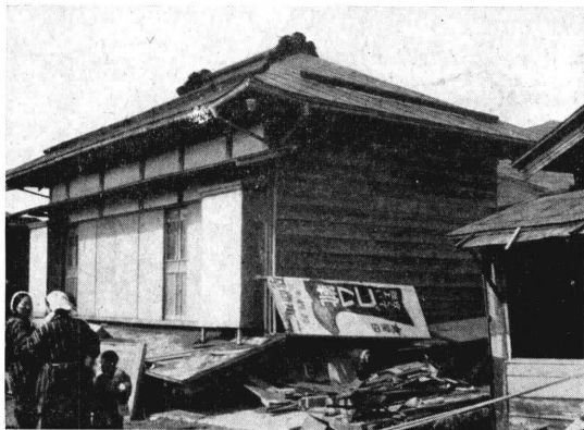
(寫眞 5) 船川港町釜川倒潰家屋, 一階が潰れてゐる
