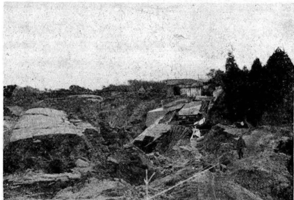
（寫眞14）北浦の相川寄りの地點，左方海岸側が崩れた爲め新道が崩れ左方に移動したと同時に陥没して民家が崩壊した，寫眞15参照
