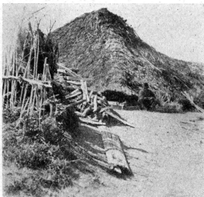
（寫眞 21）安田に於ける倒潰家屋，此邊は古い茅葺屋根が多い
