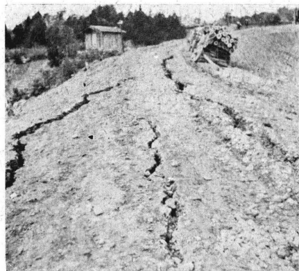
(寫眞 8) 船川港町仁井山に於ける 盛土新道の龜裂
