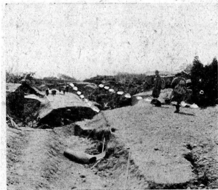
（寫眞15）寫眞14と同じ地點，白點は新道の元の位置，道路の移動陥没が明瞭である，寫眞左側が海岸で山崩れが甚だしい，此處は其の延長である
