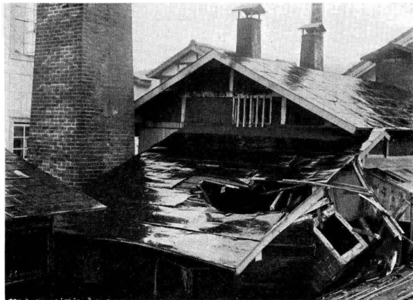
猪苗代町本町の煙突，煉瓦片となりて北方へ落下
