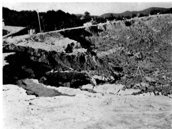
高玉鑛山に於ける堆積層崩壊 (南方より撮影)
