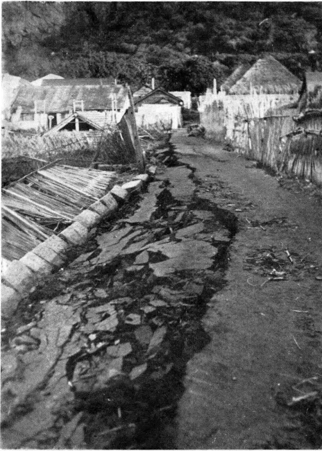
新島若郷村，道路の龜裂
