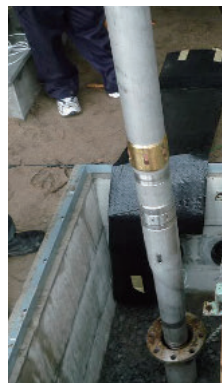
観測孔に埋設される傾斜計センサー
