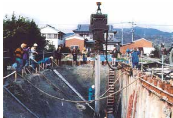
中央構造線断層帯のトレンチ調査（徳島県鳴門市）
