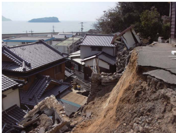
がけ崩れで損壊した道路(福岡市玄界島)
