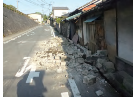
強い揺れにより倒壊したブロック塀 (2016年 熊本地震)
