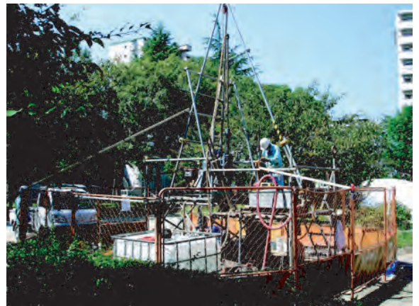
上町断層帯のボーリング調査（大阪市住之江区）
