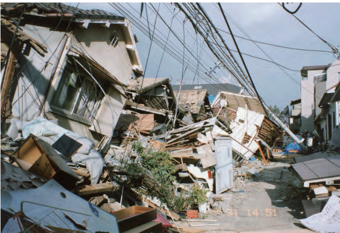
家屋の倒壊(兵庫県神戸市灘区)
