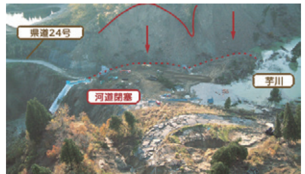
写真提供:国土交通省北陸地方整備局湯沢砂防事務所
