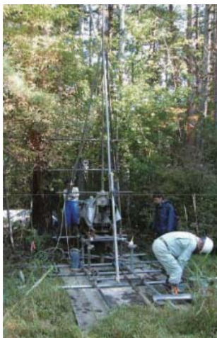
機械式ボーリング掘削
