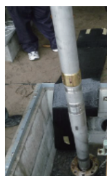
傾斜計（観測孔に埋設）
