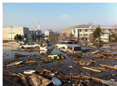
東日本大震災の津波被害
