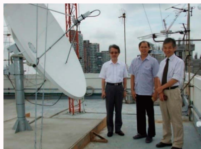
タイ気象局庁舎屋上に設置した 気象衛星ひまわり受信用のアンテナ
