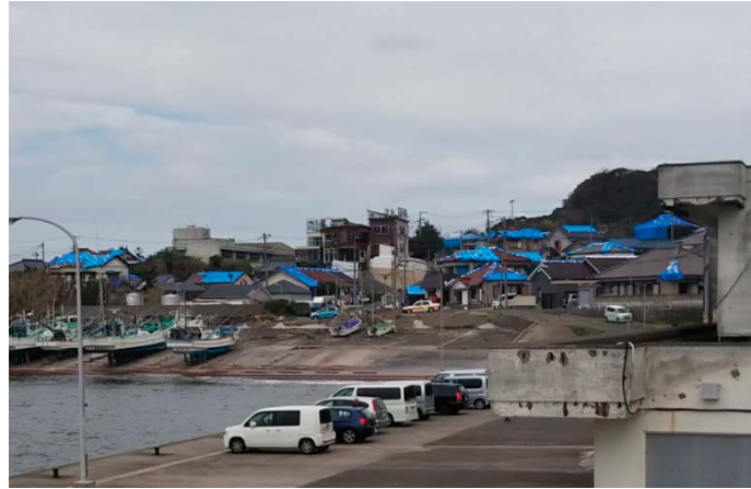
ブルーシートで屋根を保護する家屋
