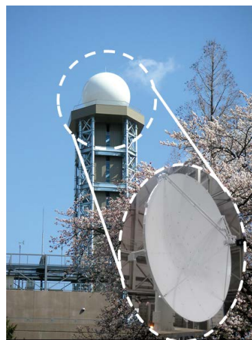
東京レーダーの外観。レーダー塔の上にある白いドーム内に、パラボラアンテナ(右下)が設置されています。
