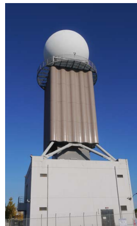
平成28年（2016年）に運用を開始した固体素子気象レーダー（成田国際空港）
