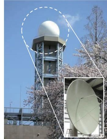
東京レーダーの外観。レーダー塔の上にある白いドームの中に、パラボラアンテナ(右下)が設置されています。
