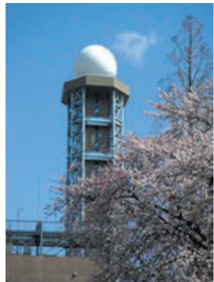
東京レーダーの外観。レーダー塔の上にある白いドームの中に、パラボラアンテナが設置されています。
