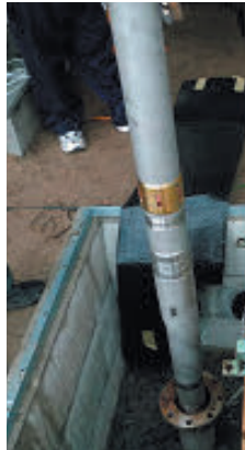
傾斜計（観測孔に埋設）
