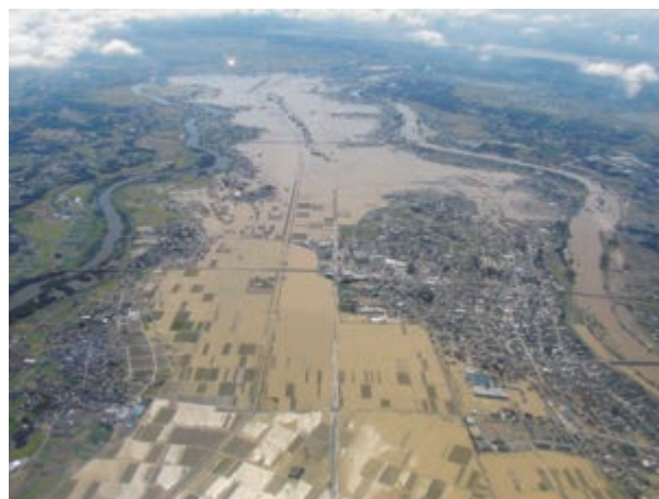
茨城県常総市の浸水被害 (提供:国土交通省関東地方整備局)
