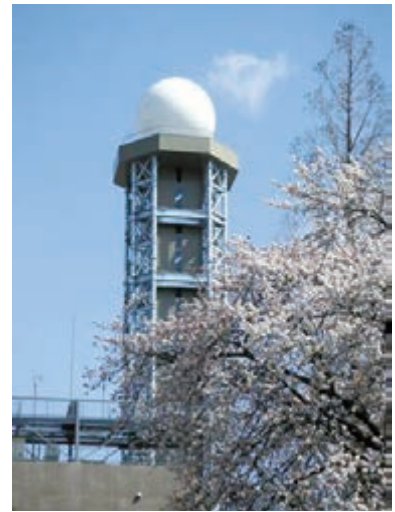
東京レーダーの外観。白いドームの中にパラボラアンテナが設置されています。
