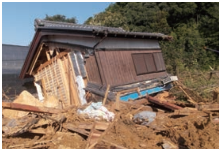
(上) 河川の洪水状況（京都府福知山市）。（提供）近畿地方整備局 (下) 土砂災害（滋賀県栗東市）
