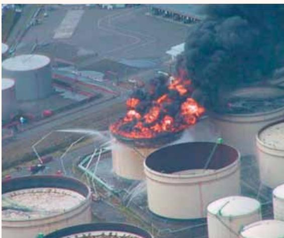
「平成15年(2003年)十勝沖地震」で、苫小牧市内で長周期地震動による石油タンクの火災が発生
