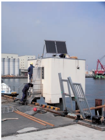
仙台新港検潮所への 観測機器設置作業の様子
