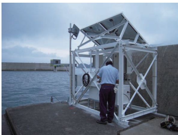
臨時観測点（鮎川）への観測機器設置作業の様子
