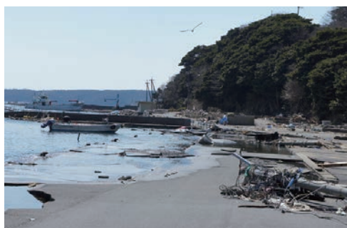
地盤沈下による浸水（宮城県石巻市）
