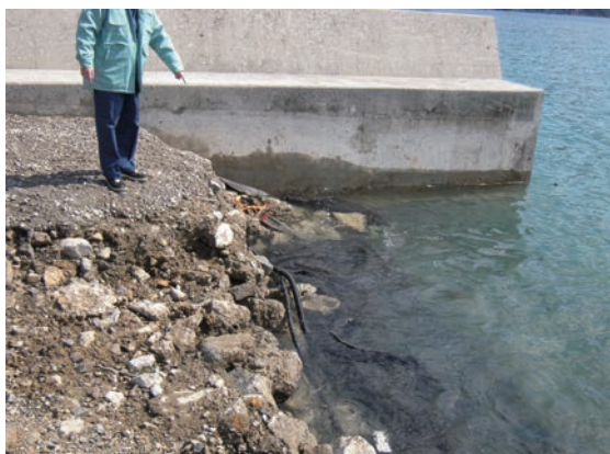
岸壁ごと施設が流失した宮古検潮所
