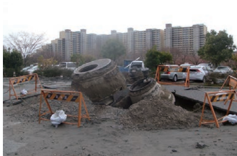
液状化によるマンホールの被害（千葉県浦安市）
