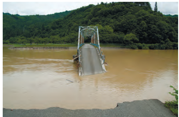
写真2.1.3.10 只見町 只見川 萬代橋 8月2日撮影
