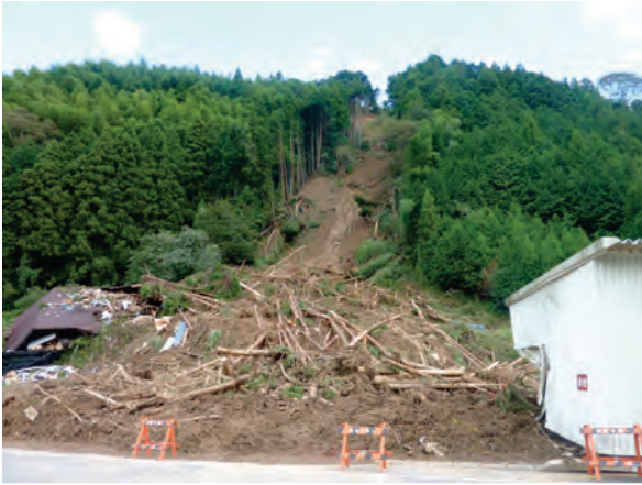
写真 2.3.3.1 静岡市清水区布沢の土砂崩れ 静岡県交通基盤部河川砂防局提供：9月23日撮影
