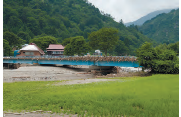
写真2.1.3.8 只見町 叶津川 8月2日撮影
