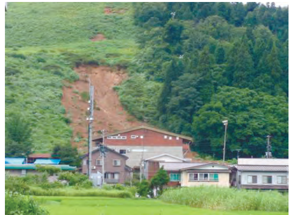
写真 2.1.3.13 南魚沼市浦佐地内の地すべり（新潟県提供）
