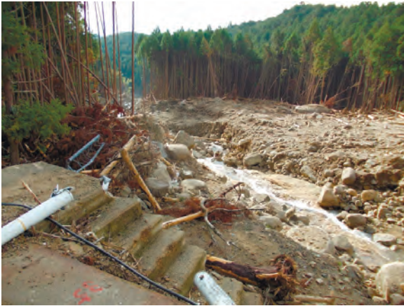
写真 2.2.3.6 那智勝浦町色川地区（太田川上流部）の土石流
