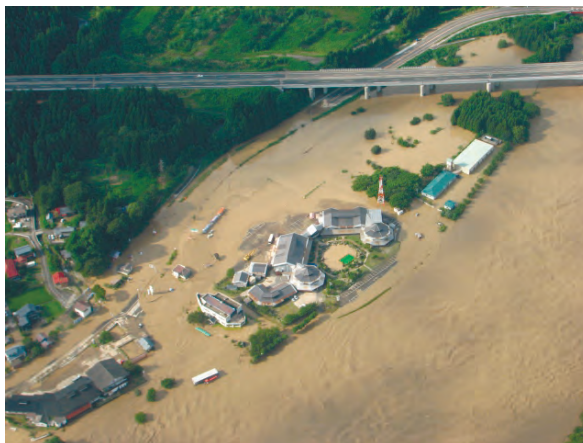
写真 2.1.3.5 阿賀野川 阿賀町「道の駅」付近浸水状況 国土交通省北陸地方整備局提供
