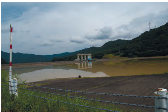
写真2.1.3.7 只見町 只見ダム 8月2日撮影
