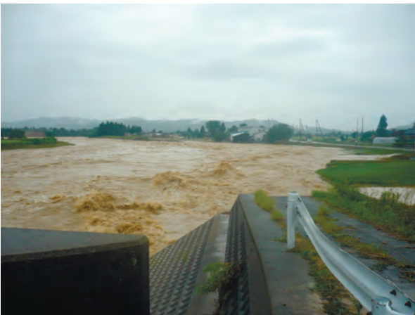
写真 2.1.3.1 五十嵐川破堤状況 新潟県土木部河川管理課提供
