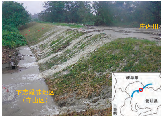
写真 2.3.3.2 庄内川左岸 31.6km 付近 (守山区下志段味地先) の堤防を越水する状況 (9 月 20 日 12 時 50 分頃, 庄内川河川事務所提供)
