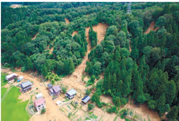
写真 2.1.3.12 十日町市麻畑地内のがけ崩れ（新潟県提供）
