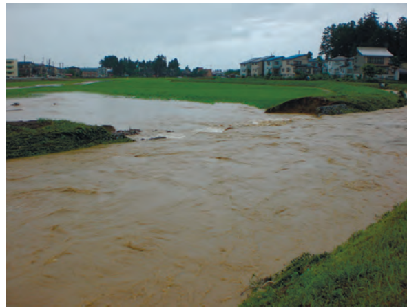
写真 2.1.3.2 茶郷川破堤状況 新潟県土木部河川管理課提供
