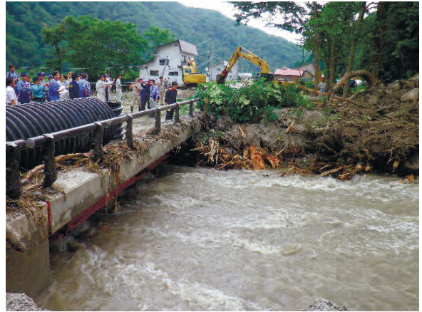
写真2.1.3.9 南会津町 小立岩 伊南川 8月2日撮影
