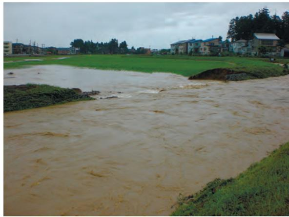
写真 2.1.3.2 茶郷川破堤状況
