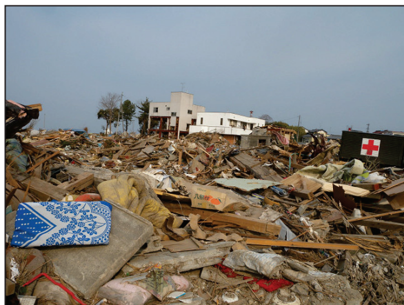
写真 270 相馬市② 原釜地区の被害状況
