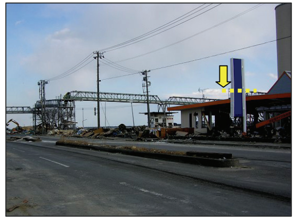
写真138 津波の痕跡（第3.2.102図の138） 看板に痕跡を確認
