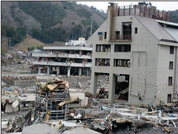
写真 257 女川町③ 女川港付近の被害状況
