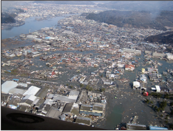
写真 261 石巻市① 旧北上川東側 市内の被害状況 (3/12 撮影)
