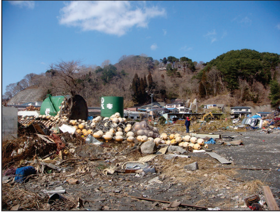
写真 228 宮古市① (宮古検潮所付近) 津波により倒壊した燃料タンク
