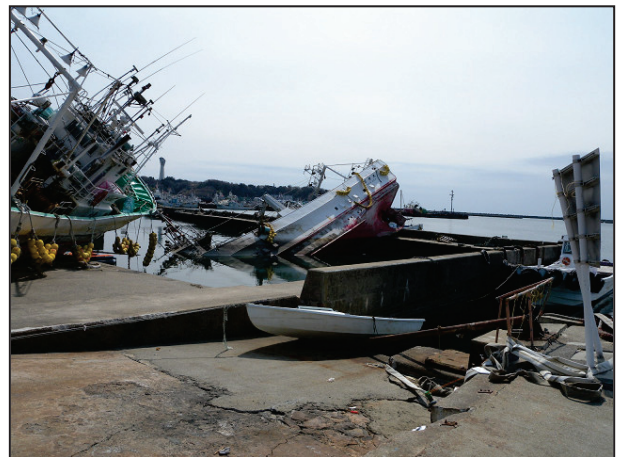
写真 276 いわき市小名浜② 小名浜漁港の被害状況
