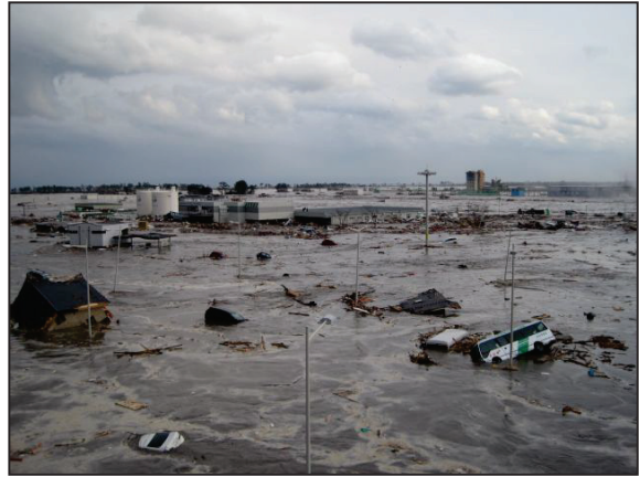
写真 268 仙台空港④ 3/11 撮影 空港周囲の被害状況
