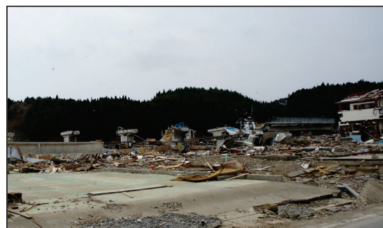
写真 254 南三陸町② 津波で落橋した歌津大橋
