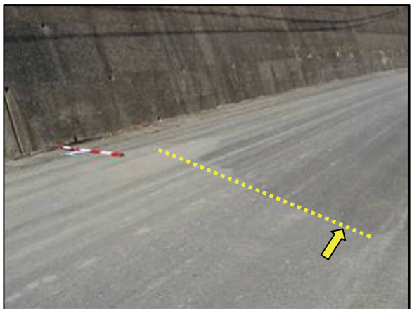
写真 211 津波の痕跡 (第 3.2.142 図の 214) 黄色破線まで浸水
