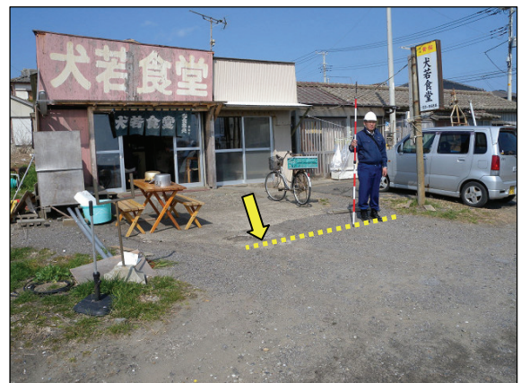
写真170 目撃証言による津波の浸水域 (第3.2.123図の173) 黄色破線まで浸水
