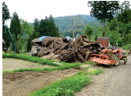
写真 153 倒壊した民家 (第 3.3.23 図-⑥)
