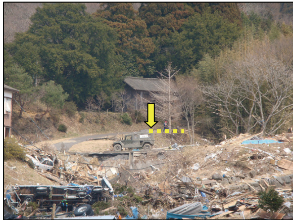
写真118 津波の痕跡（第3.2.90図の118） 漂着物を確認
