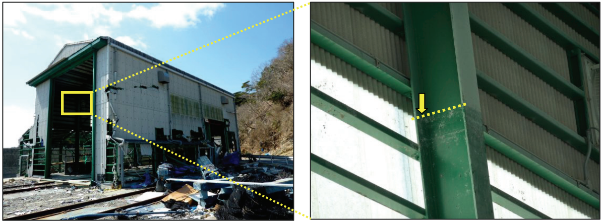
写真123 津波の痕跡（左写真の黄色枠内が右写真に対応する。第3.2.93図の122）
