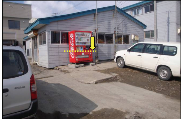
写真27 津波の痕跡 (第3.2.29図の27)
