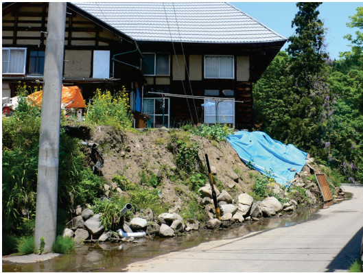
写真125 石垣の崩落 (第3.3.15図-③)
