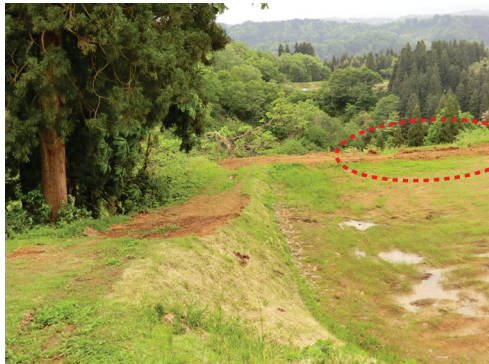
写真 142 水田畦部分修復跡 (第 3. 3. 20 図-③)
