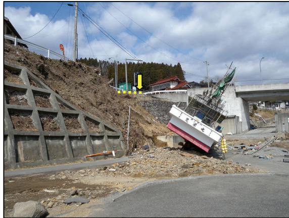
写真110 津波の痕跡 (第3.2.86図の110) 漂着物を確認
