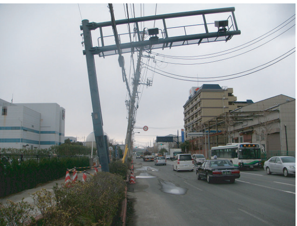
写真 116 舞浜（浦安市総合運動公園前） 電柱等の傾き
