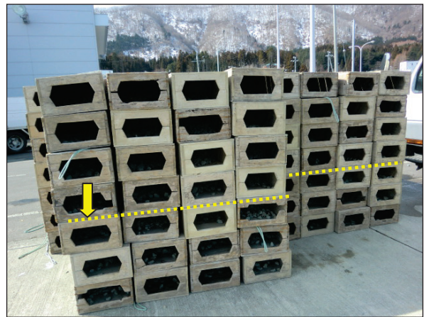
写真73 津波の痕跡 (第3.2.64図の73)
