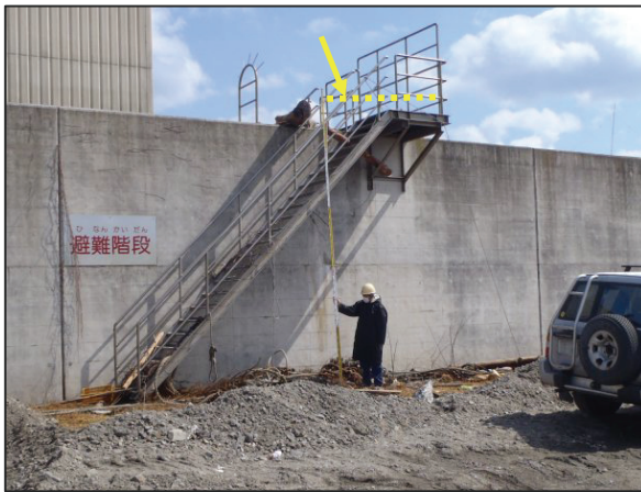
写真95 津波の痕跡（第3.2.82図の96） 黄色破線の位置で漂着物を確認
