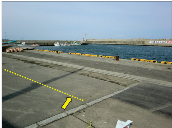
写真74 目撃証言による浸水地点 (第3.2.65図の74) 黄色破線まで浸水
