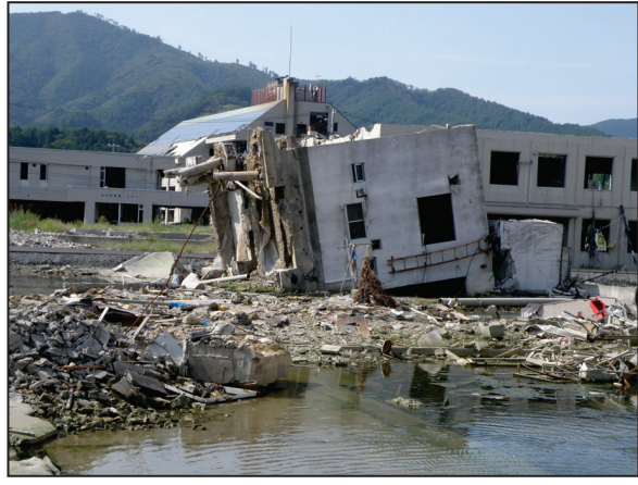
写真 256 女川町② 基礎から倒壊したコンクリート建造物
