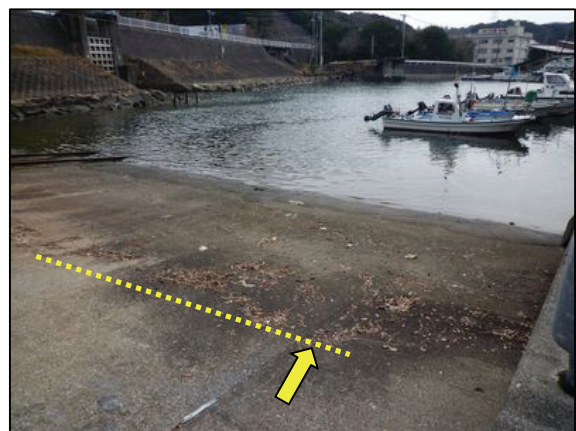
写真204 津波の痕跡（第3.2.138図の207） 津波による漂着物を確認
