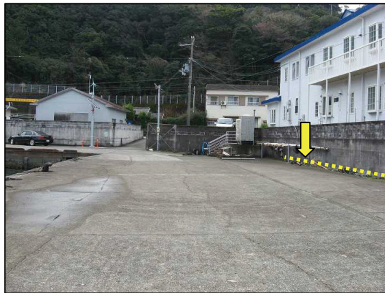
写真203 津波の痕跡（第3.2.137図の206） 津波による漂着物を確認
