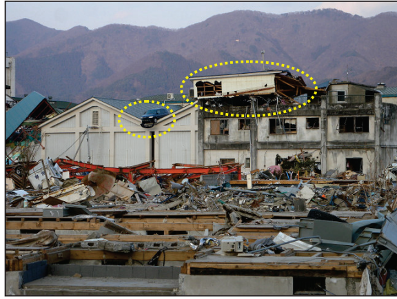
写真 247 大船渡市大船渡町④ 野々田 倉庫の屋根，屋上に漂着した車や家屋
