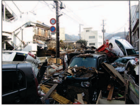
写真 235 釜石市④ 市内中心部の被害状況
