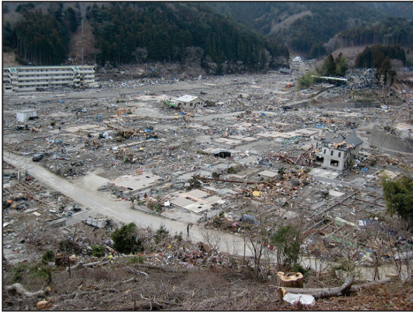
写真 255 女川町① 町内の被害状況
