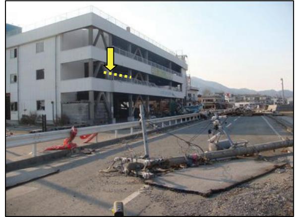
写真 114 津波の痕跡 (第 3.2.88 図の 114) 漂着物を確認
