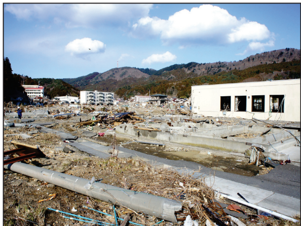
写真 260 石巻市鮎川浜② 鮎川浜の被害状況
