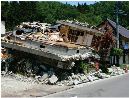
写真120 民家の倒壊（一部撤去済）(第3.3.14図-②)
