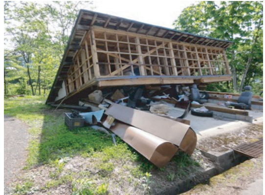
写真139 車庫の倒壊(第3.3.18図-⑤)
