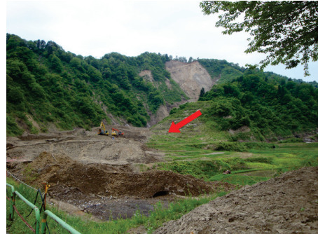
写真146 国道353号沿いの土砂崩れ復旧作業 (第3.3.22図-①)
