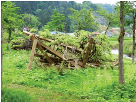
写真 150 公園内の倒壊した建物(第 3.3.23 図-③)
