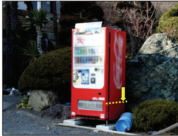
写真128 津波の痕跡 (第3.2.95図の128)
