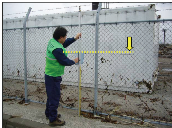
写真37 津波の痕跡（第3.2.40図の37） フェンスで漂着物を確認
