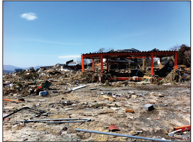
写真 274 南相馬市② 市内の被害状況
