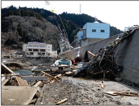
写真 240 大船渡市三陸町綾里③ 綾里漁港の被害状況
