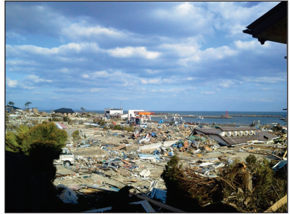
写真 264 七ヶ浜町② 菖蒲田浜漁港付近の被害状況
