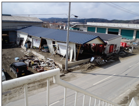
写真 227 久慈市(久慈験潮所付近) 津波により全壊した魚市場裏側の建物
