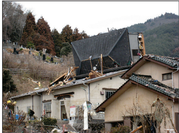
写真 258 女川町④ 女川港付近の被害状況
