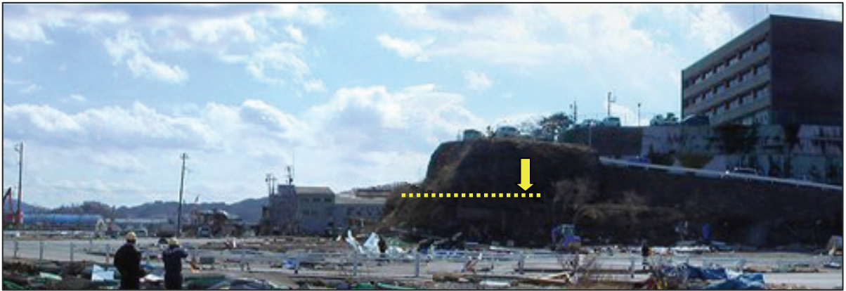
写真102 津波の痕跡（第3.2.83図の102）漂着物を確認
