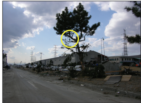
写真136 津波の痕跡（第3.2.102図の136） 黄色丸内で漂着物を確認
