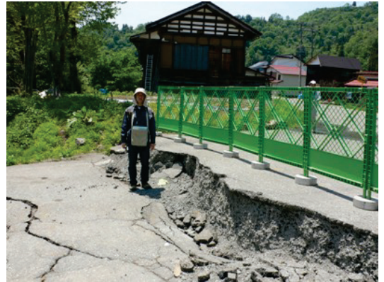
写真126 橋梁取付け道路の陥没 (第3.3.15図-④)
