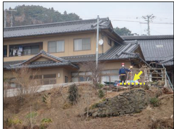
写真119 津波の痕跡（第3.2.91図の119） 漂着物を確認
