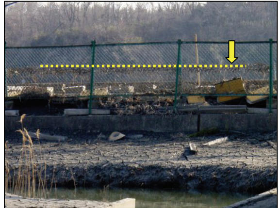
写真131 津波の痕跡 (第3.2.98図の131) フェンスに漂流物を確認
