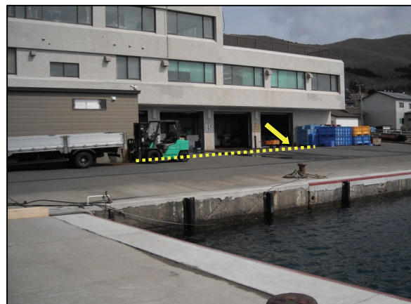
写真79 目撃証言による浸水地点 (第3.2.72図の80) 黄色破線まで浸水
