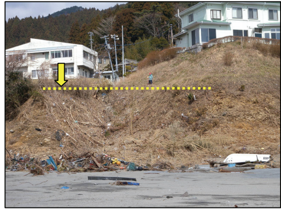
写真108 津波の痕跡 (第3.2.85図の108) 漂着物を確認
