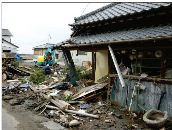
写真 282 旭市② 下永井地区の被害状況 多数の民家が津波により被害
