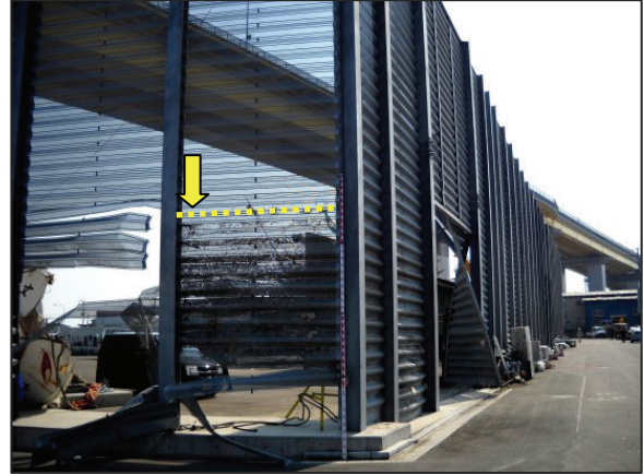
写真88 津波の痕跡。フェンスで漂着物を確認。 (第3.2.80図の89)
