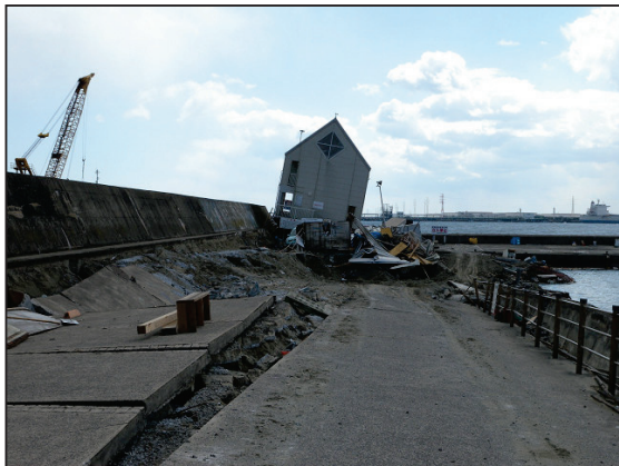
写真 277 鹿嶋市① 鹿嶋港魚釣園付近の被害状況
