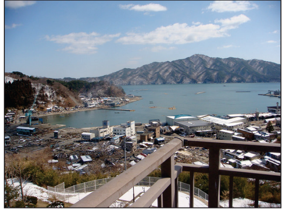
写真 229 宮古市② 市内の被害状況
