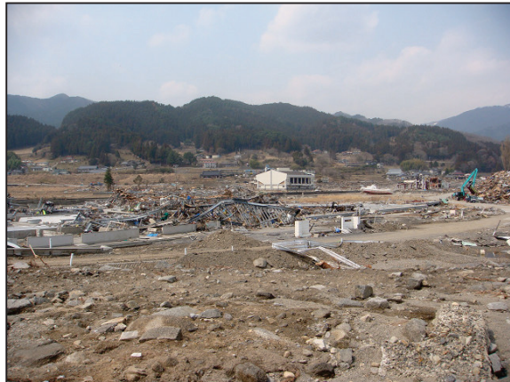
写真 237 大船渡市三陸町起喜来② 市内の被害状況
