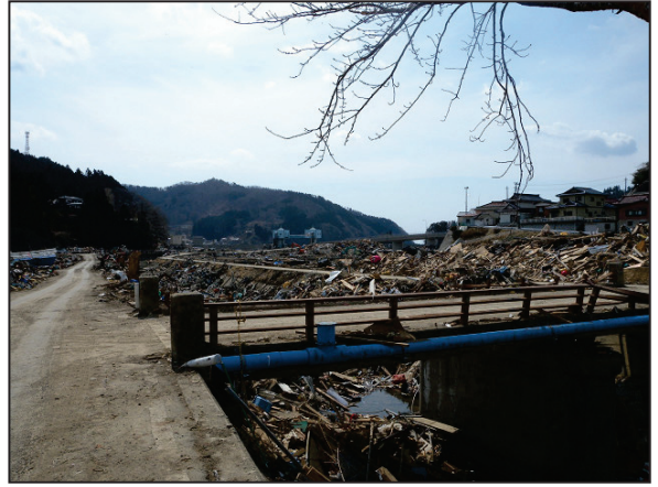
写真 241 大船渡市三陸町綾里④ 綾里川沿いの被害状況
